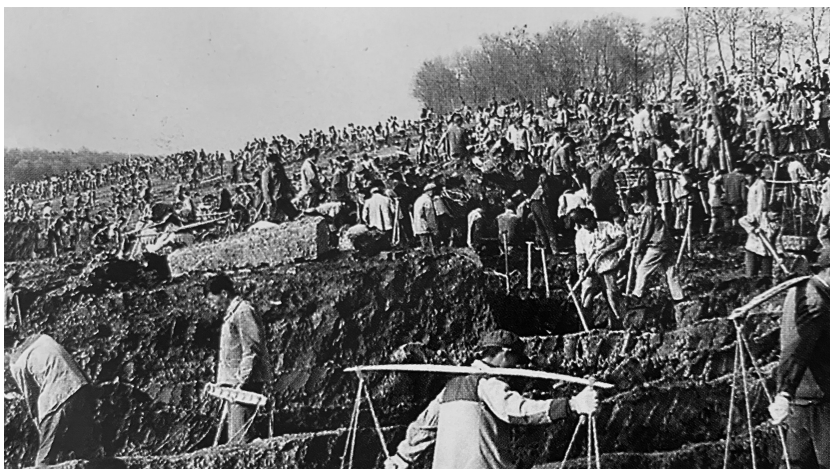
民工奋战在拓浚运河工地上
