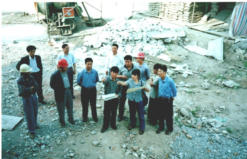
同济大学熊岳生教授率领的专家团队与县领导在妙通塔施工现场
