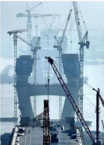
常泰长江大桥：世界最大 跨度斜拉桥
