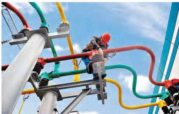
电工在淮南—南京—上海线1000千伏交流特高压输变电工程施工 刘仁军 摄
