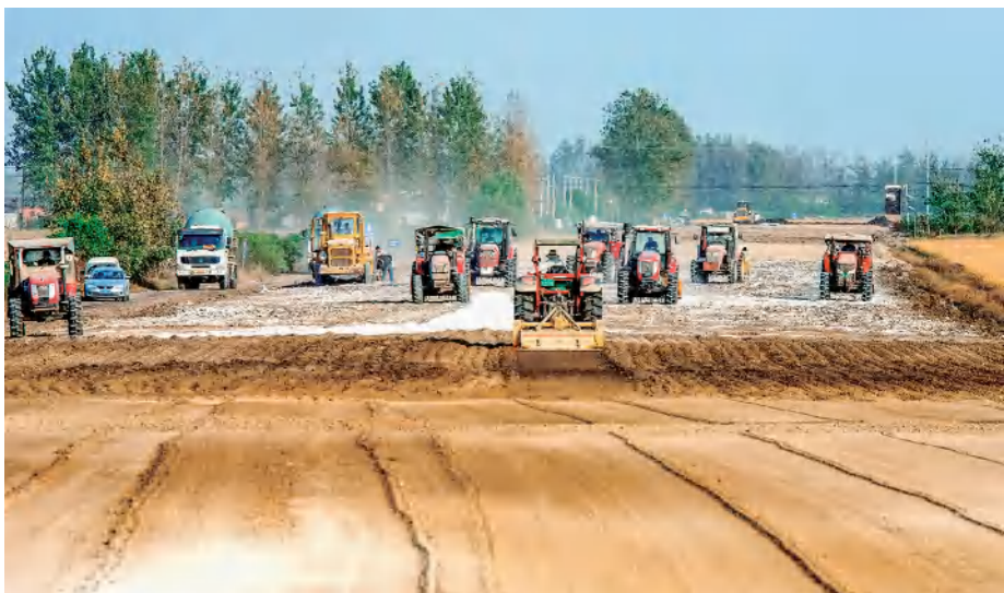
省道420吕良幸福港东侧施工场景（2019年摄）
