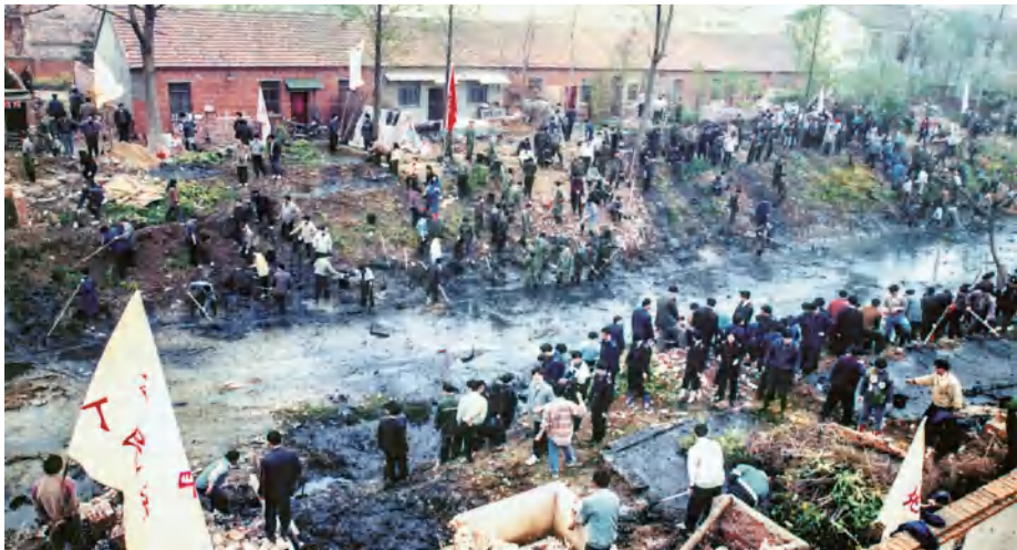
县城利民河施工现场
