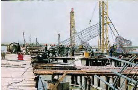
建设中的金湖大桥 朱伟 摄
