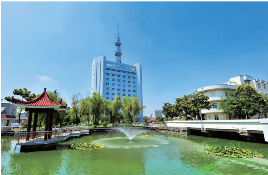
金湖县供电公司（2018年摄）
