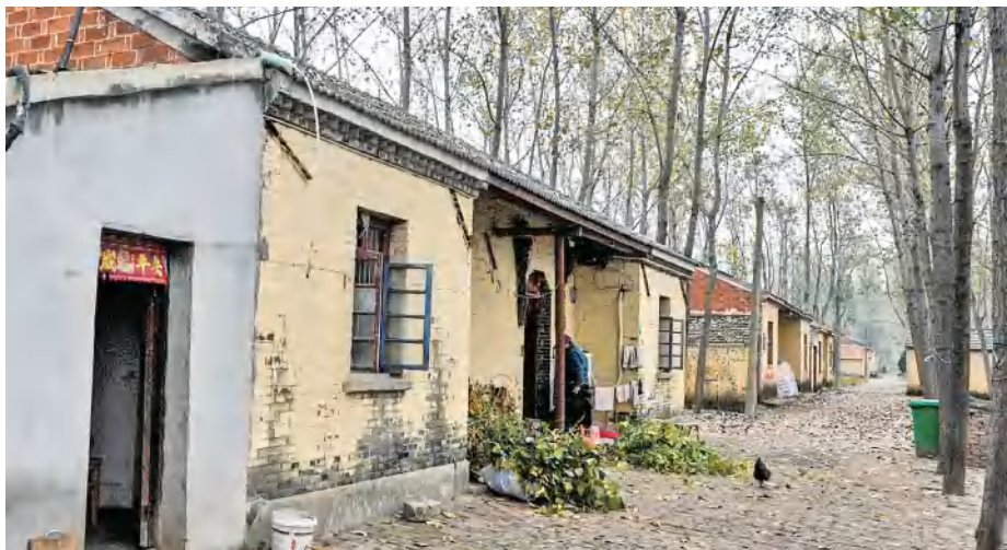
吕良集镇拆迁户在集镇西北兴建的新村庄台（2010年摄）
