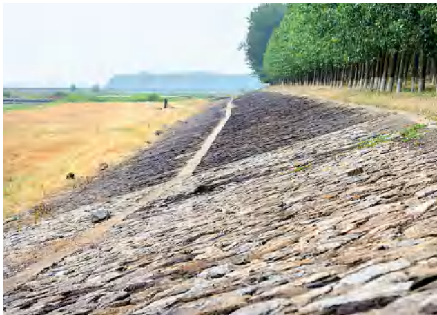
高邮湖大堤块石护坡（2017年摄）
