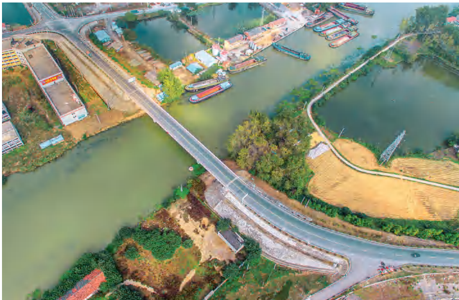
石港大桥（2016年摄）
