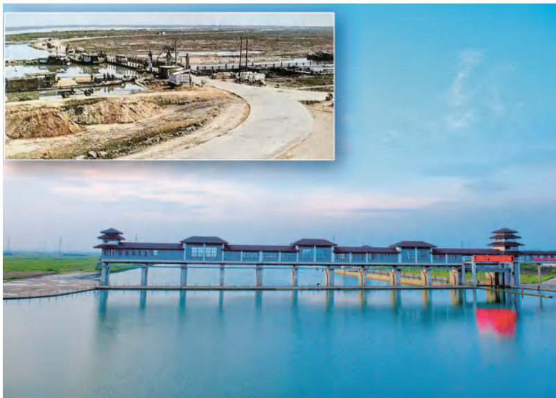
新旧西偏泓船闸、节水闸（主图 2017 年摄）
