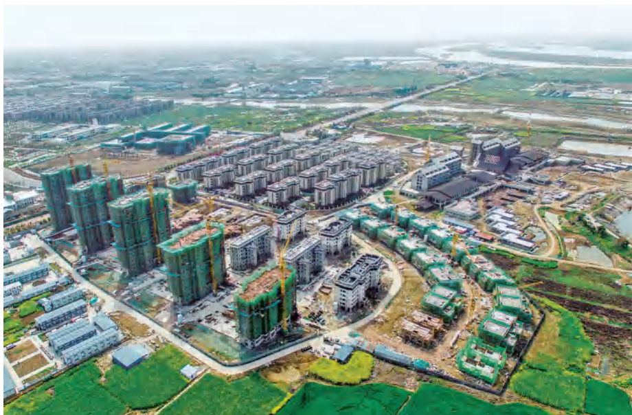
建设中的明发国际游艇小镇(2020年摄)
