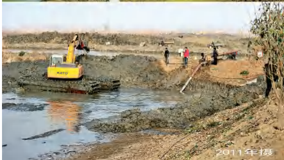
机械化施工水利工程
