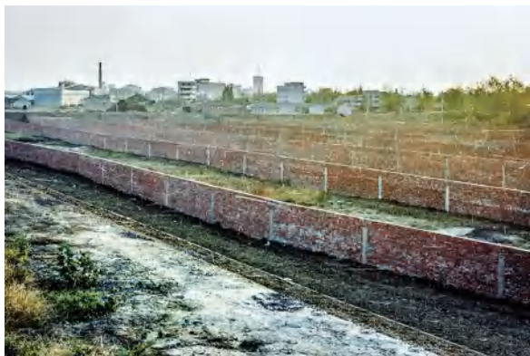
县造纸厂污水处理池（1998年摄）
