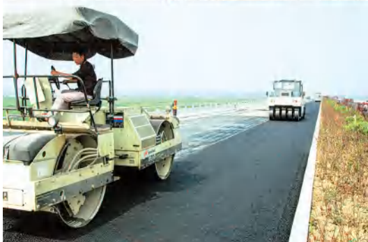
金湖大桥加宽施工
