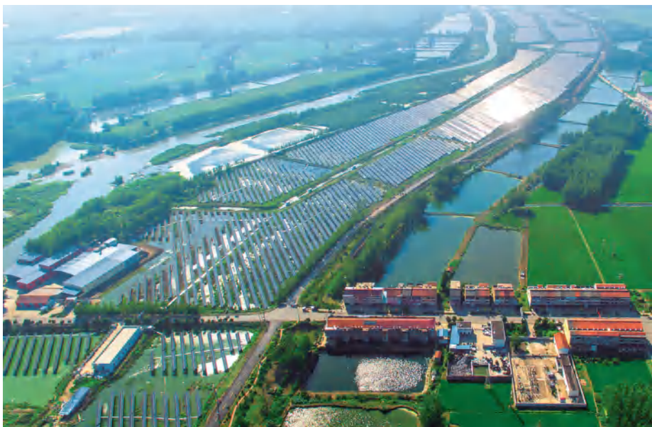
吕良镇老三河内光伏发电工程（2017年摄）
