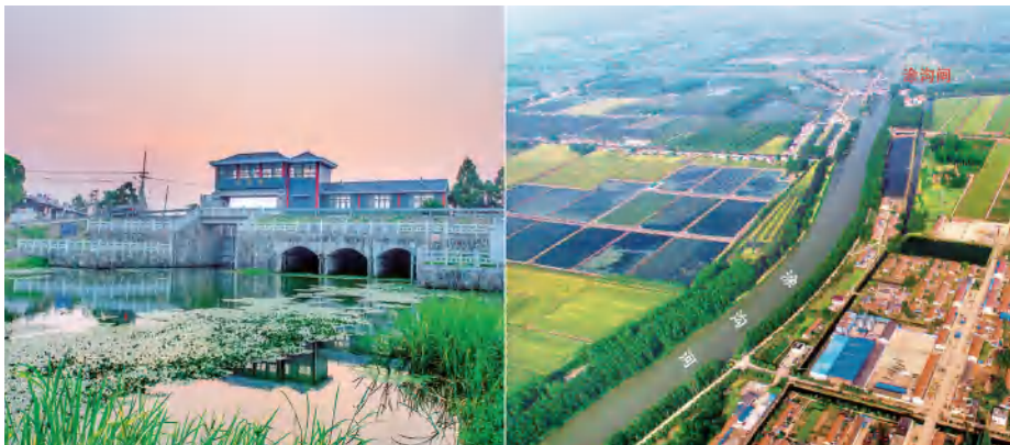
涂沟河、涂沟闸（2018年摄）
