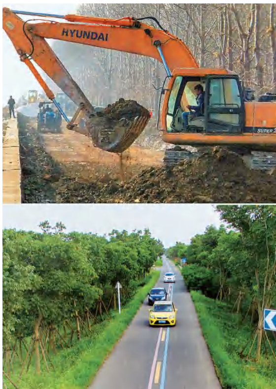
县环湖绿道及拦河大坝副坝改造工程
