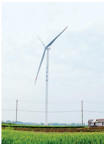
塔集镇内兴建的风力发电机
