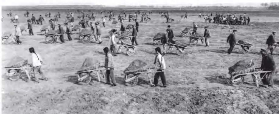
淮河入江水道工程施工场景
