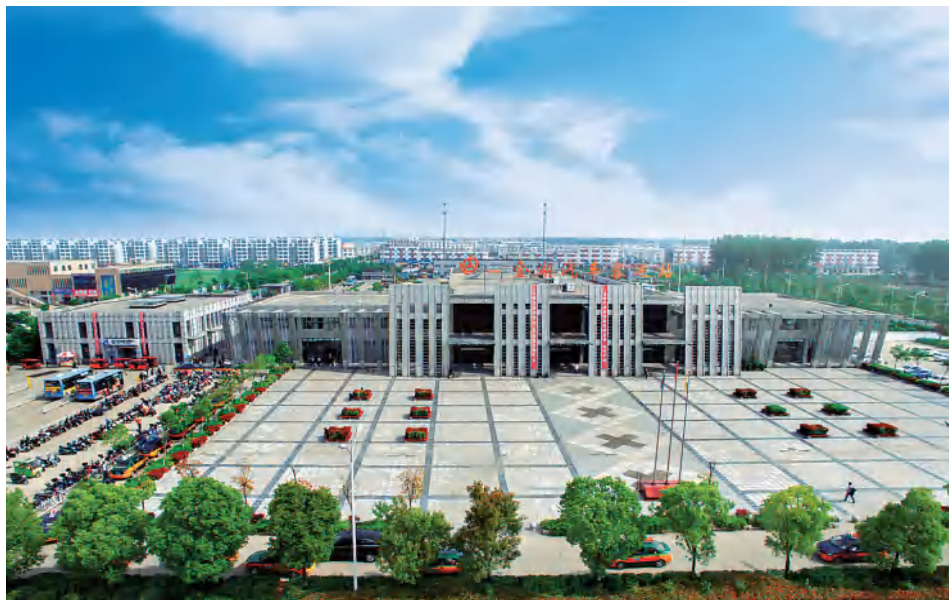
金湖汽车客运站（位神华东路北、东阳路东，2010年2月启用）
