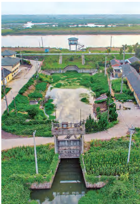
淮河入江水道东大堤塔集套闸(2019年摄)
