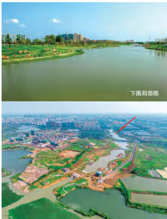
城西引水河工程暨局部图（2019 年摄）
