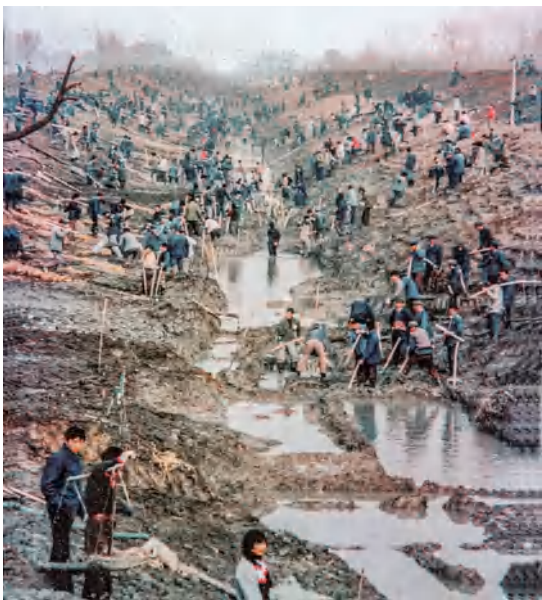
疏浚河道现场
