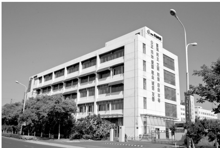
苏益电器股份有限公司厂房
