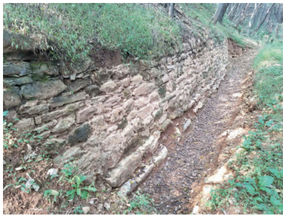
图8 盱眙古城墙遗址
